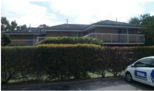
Unit 19, 322 Canning Highway St, Como
